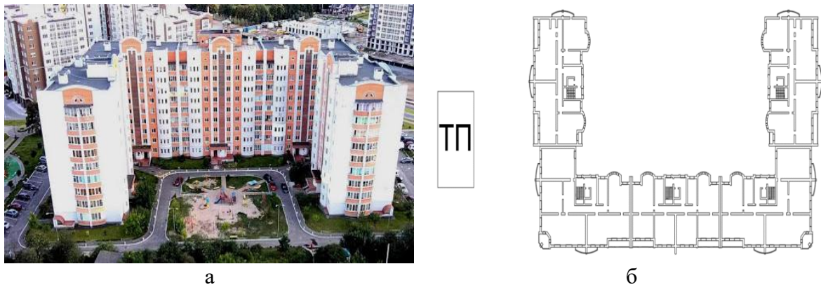
Рисунок 1 – Зовнішній вигляд основного фасаду будівлі (а) та план забудови (б)
