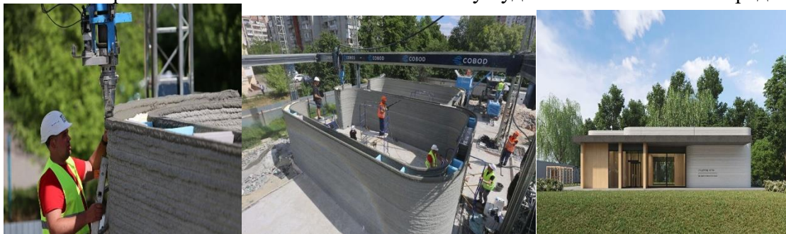
Рисунок 1. Процес будівництва школи за новою технологією 3D принтера
