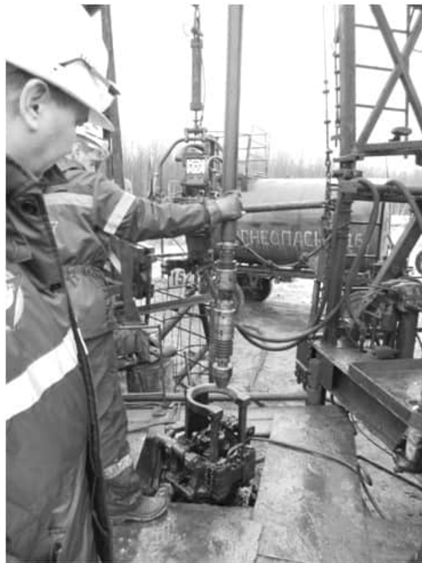
Рис. 13 – Спуск підземного обладнання комплексу «Імпульс» в нафтову свердловину
