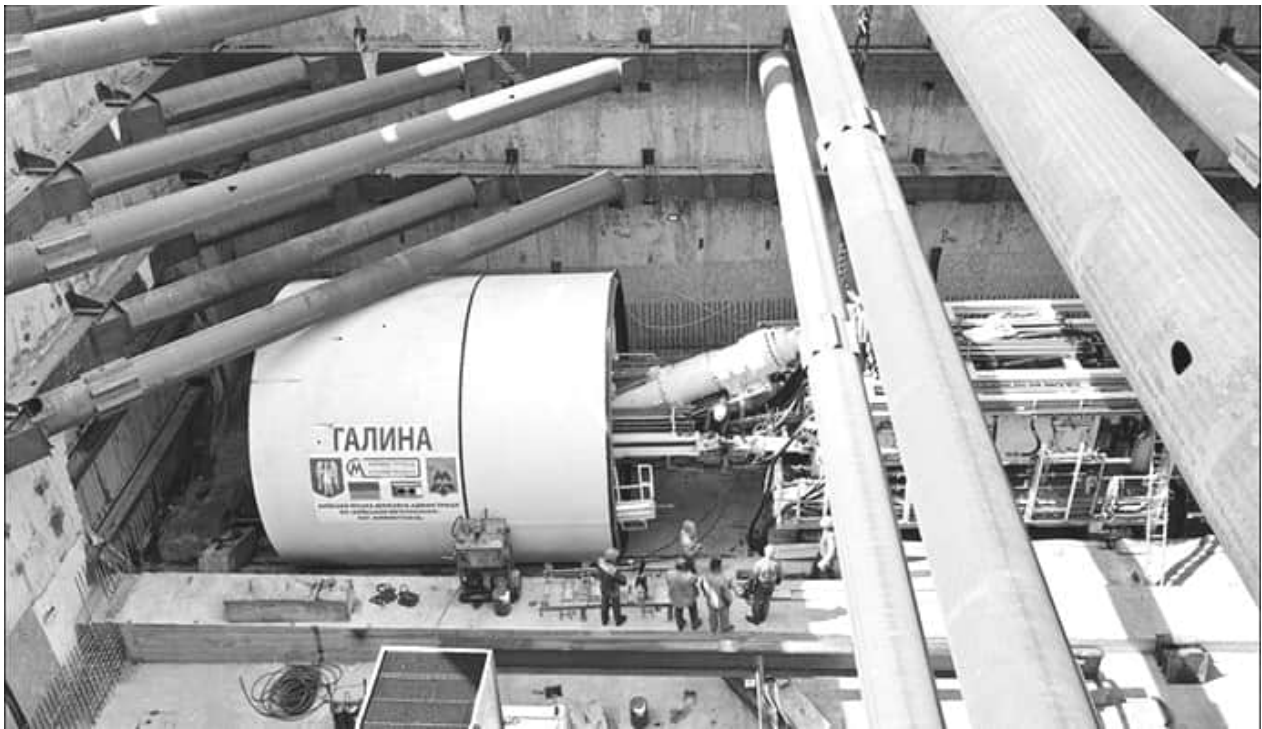
Рис. 9 – Проходження практики студентами кафедри геоінженерії на будівництві Київського метрополітену
