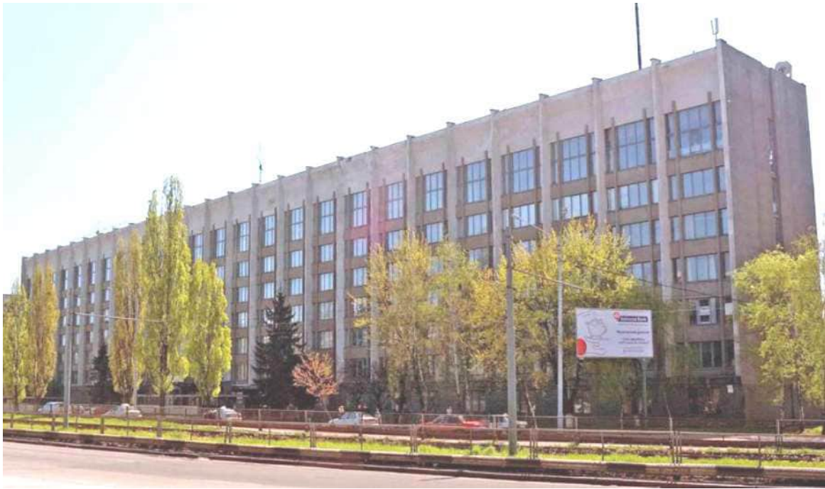
Рис. 7 – Навчальний корпус №22 НН ІЄЕ (м. Київ, вул. Борщагівська, 115)
