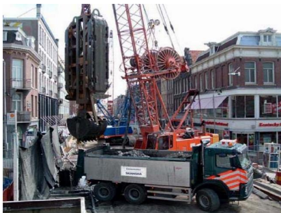
а) б) Рисунок 6 – Навісне обладнання для утворення «стіни в ґрунті»
