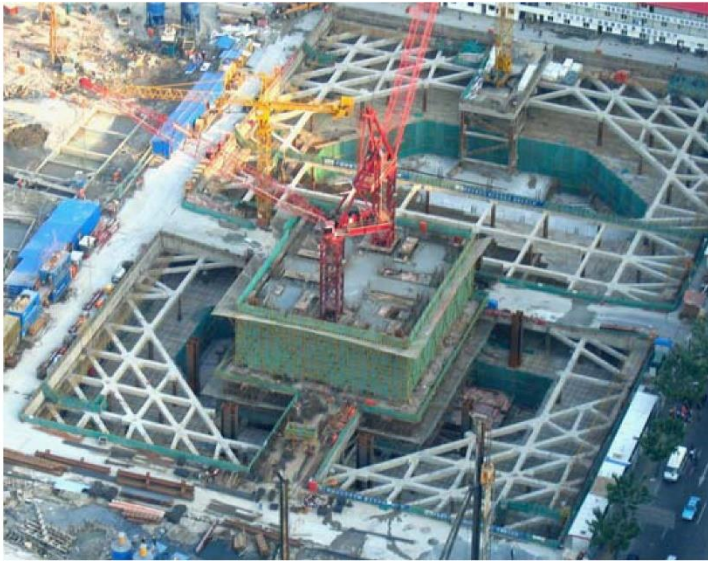
Рисунок 12 – Розпірне кріплення котлованів за допомогою горизонтальних (а) і вертикальних (б) ферм
