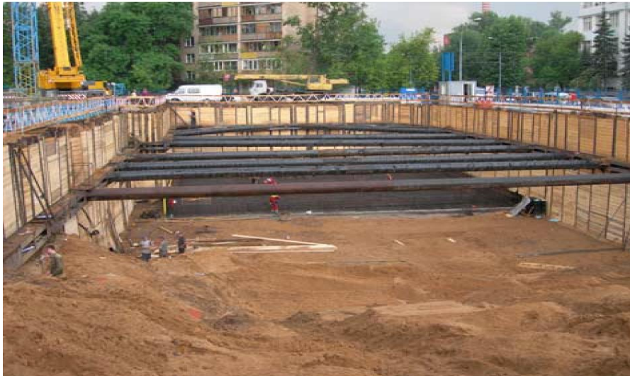
Рисунок 3 – Огородження котловану зі сталевих елементів із забіркою
