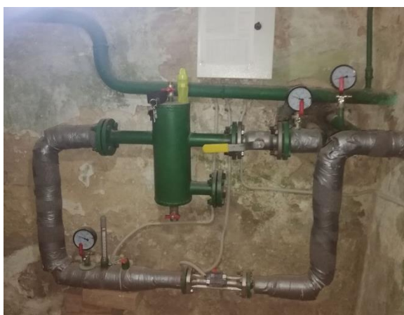
Рисунок 1 – Обладнання ІТП житлового будинку Відрадий маєток по адресі пр. Відрадий 71/2
