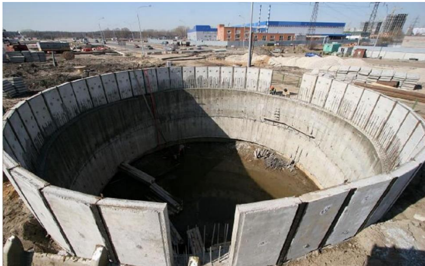
Рисунок 2 – Занурення збірно-монолітного опускного колодязя
