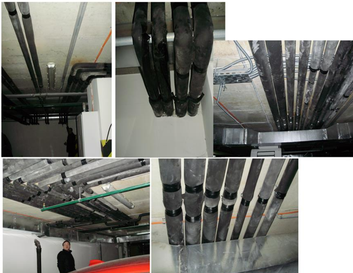
Рисунок 3 – Теплові комунікації в паркінгу.
