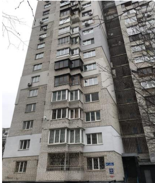
Рисунок 1 – Зовнішній вигляд житлової будівлі, що досліджується
