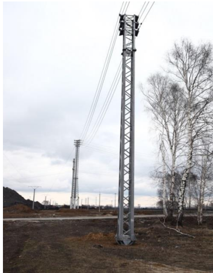
Рисунок 2. Металева опора з гнутого профілю в полі
